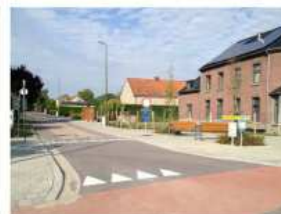
Kruising Stationsstraat - Stationsplein
