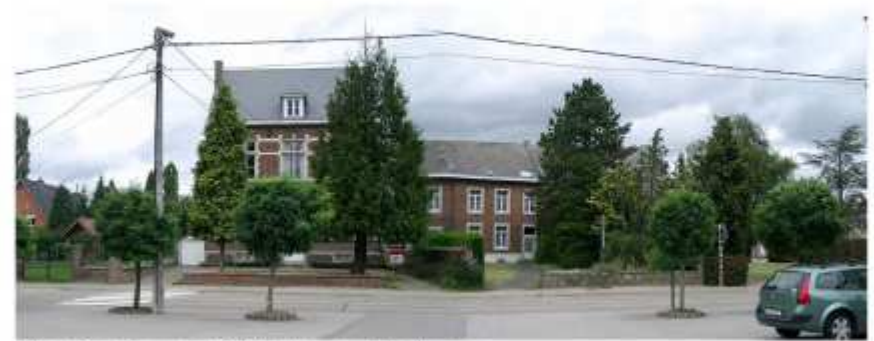
Zicht vanaf Grote Steenweg (kant DCMW) richting voormalig kloostergebouw
