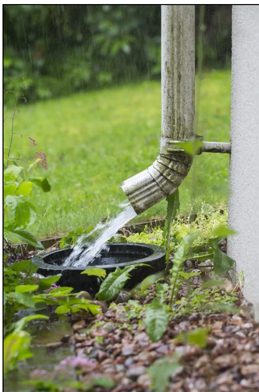
Figuur 31: Afkoppelen dakafvoer van het afvoerstelsel.
