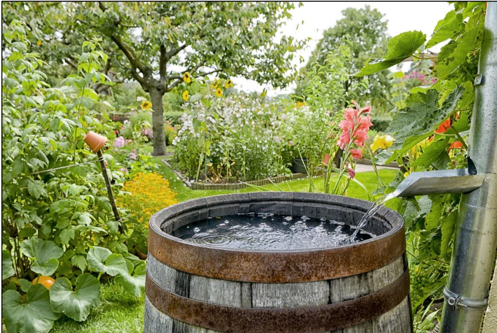
Figuur 32: Regenwaterton voor hergebruik van regenwater.
