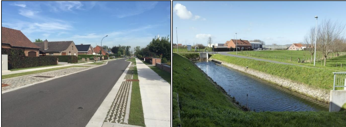
Figuur 33: Links: Lokale infiltratie wegverharding en fietspad. Rechts: Infiltratiebekken.
